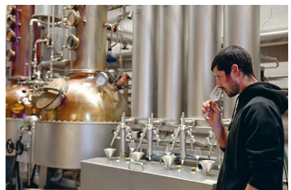
Arbeiten am Brennshafen.
